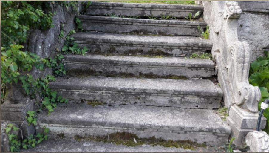
Immagine 17 - interna – Scala monumentale
